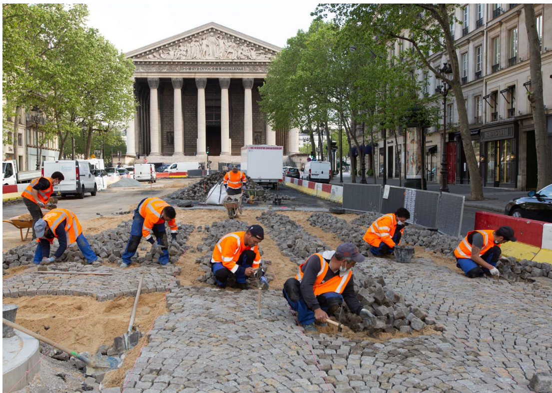
Pavage de la rue Royale, 8 e - Les travailleurs de la construction et des travaux publics sont particulièrement exposés à la chaleur. Des arrêts de chantier sont à anticiper en période de canicule. (Crédits Christophe BELIN / Ville de Paris)
