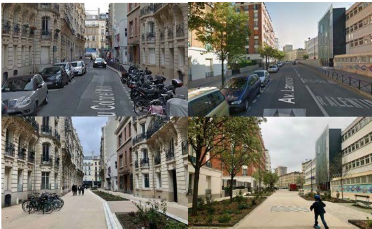
Deux rues parisiennes désimperméabilisées et végétalisées. (Source : compte twitter @EmmanuelSPV )
