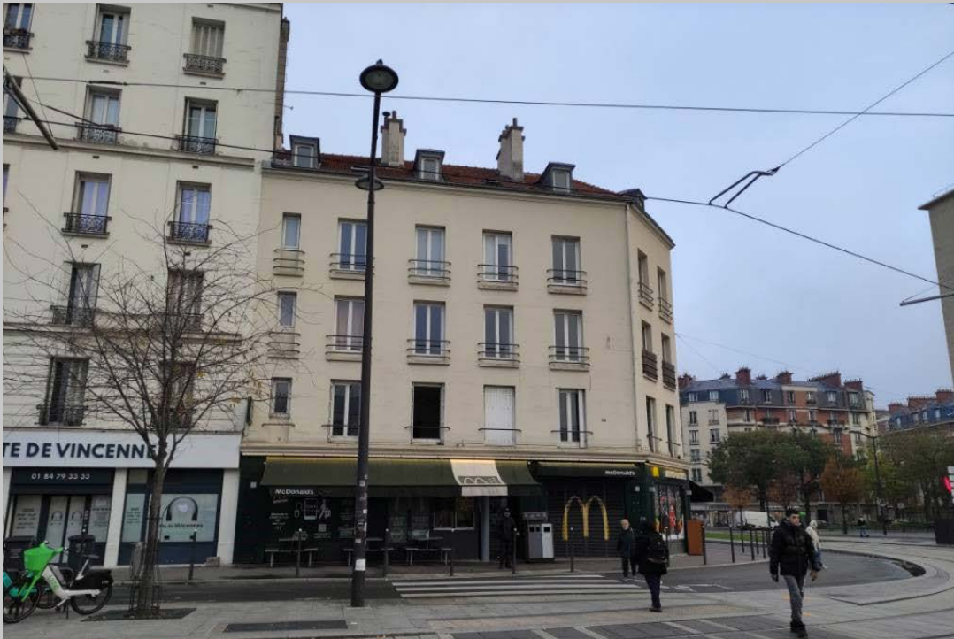
Immeuble privé, cours de Vincennes, 20 e (Crédits Nicolas ROSE / Ville de Paris)
