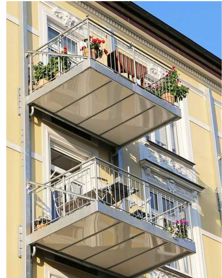
Ajout de balcons rapportés sur une construction existante Berlin
