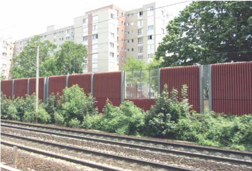
Exemple de mur acoustique à Saint-Denis - RER D - SNCF Réseau
