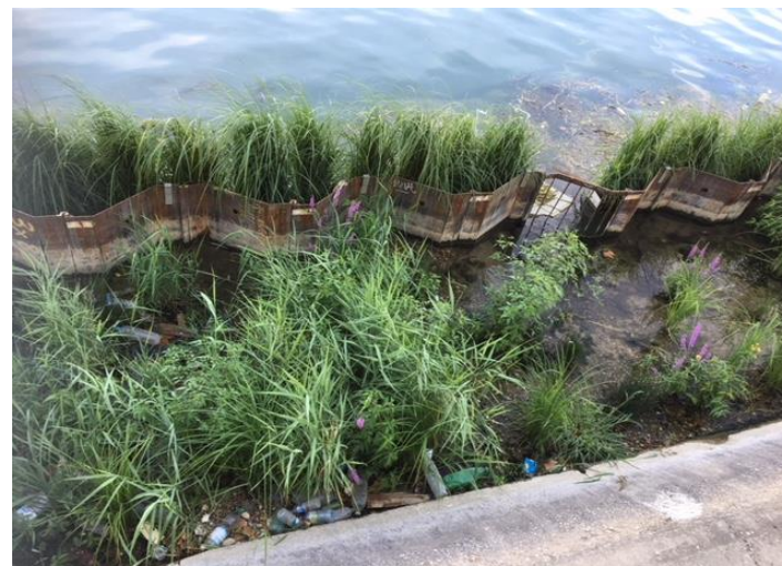
Roselière palplanche créée par Ports de Paris, pont du Garigliano (16e arrdt) en nov 2017
